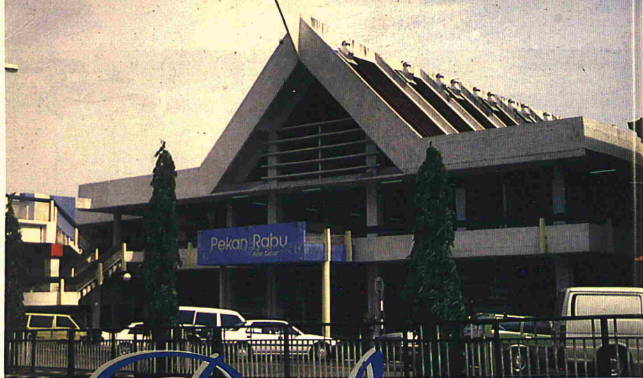
Bangunan Pekon Rabu
